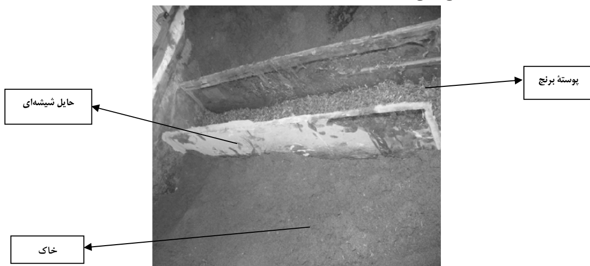
شکل ۲. حایل برای ریختن پوسته در داخل ترانشه
